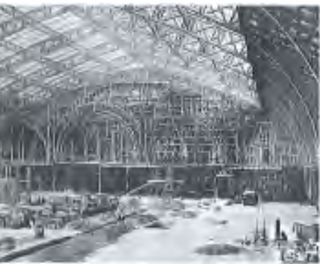
A Sala das Festas em construção na antiga Galeria das Máquinas.
