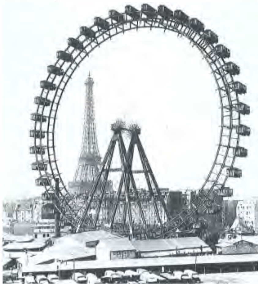
A Grande Roda com as suas quarenta cabines suspensas, e a rodar a cem metros de altura do solo não foi, contudo, a maior das atracções.
